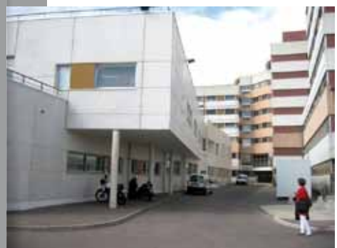
CENTRE HOSPITALIER DE SENS — Construction des urgences (89);
