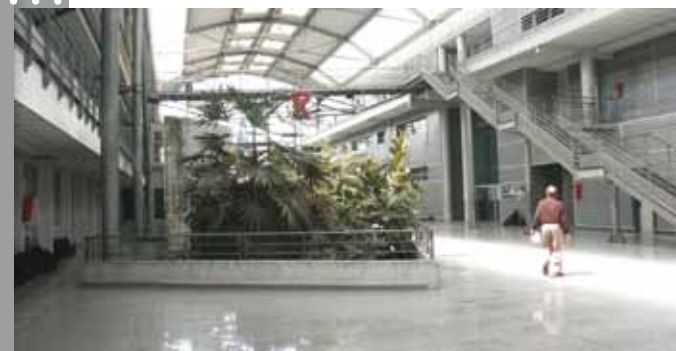
REGION PACA — Reconstruction du lycée Diderot à Marseille (13)
