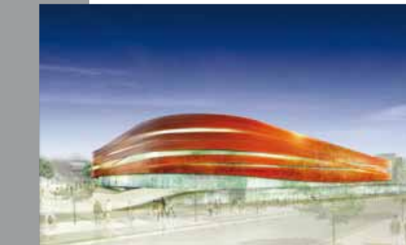
VILLE DE LYON — Construction de la Halle d'Athlétisme de la Duchère à Lyon (69) ; J. Chabanne
