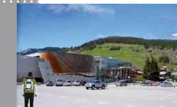
VILLE DE MEGÈVE — Reconstruction et extension du Palais des Sports de Megève (74) ; Groupement ARCOS Architecture
