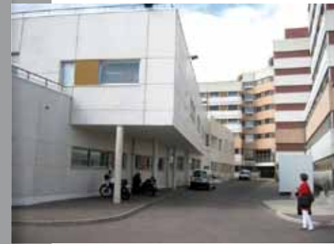
CENTRE HOSPITALIER DE SENS — Construction des urgences (89) ;
